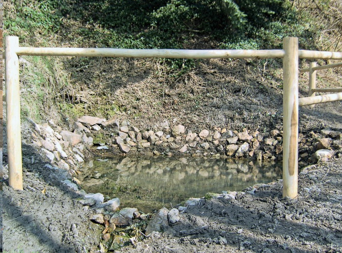
La Font Gallou est implantée le long d'un chemin de randonnée à l'extérieur du village. Le débit de cette fontaine est constant, même en été. Elle a fait l'objet de travaux de réaménagements paysagers.
