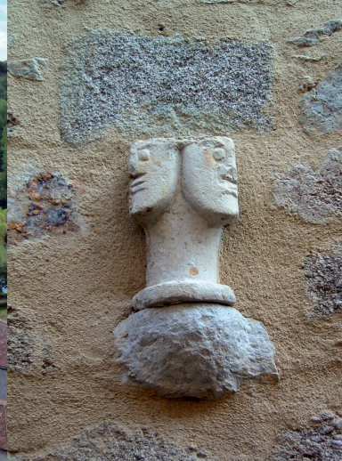
La maison possédant cet élément compte également plusieurs linteaux en accolade. L'origine de cette pierre de remploi est inconnue.
