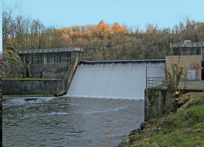
Le barrage de l'Issoire (aussi appelé barrage de Bellevue) a permis de constituer une réserve en eau potable d'environ 750 000 m 3 . Il est géré par le Syndicat d'Eau Potable, tout comme la station de traitement des eaux implantée à Bellevue.
