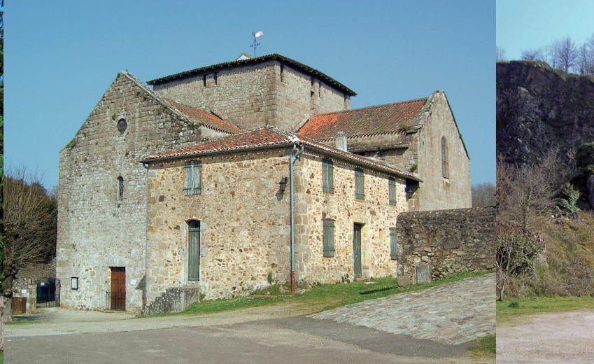
L'église Saint-Vincent, en tant qu'ancienne chapelle castrale, est accolée à la basse-cour. Le plan en croix grecque de l'édifice est en partie dissimulé par le presbytère, construit au milieu du XIX e siècle.
