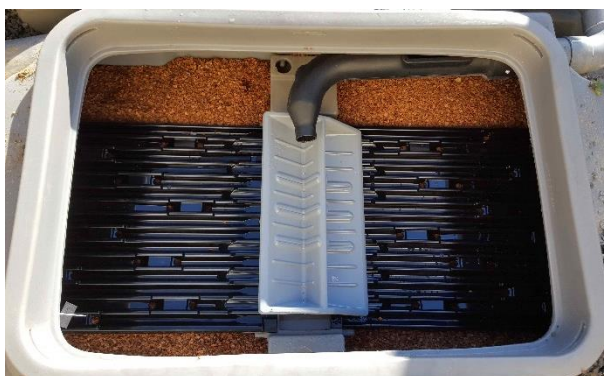
Exemple : Filtre à copeaux de coco
